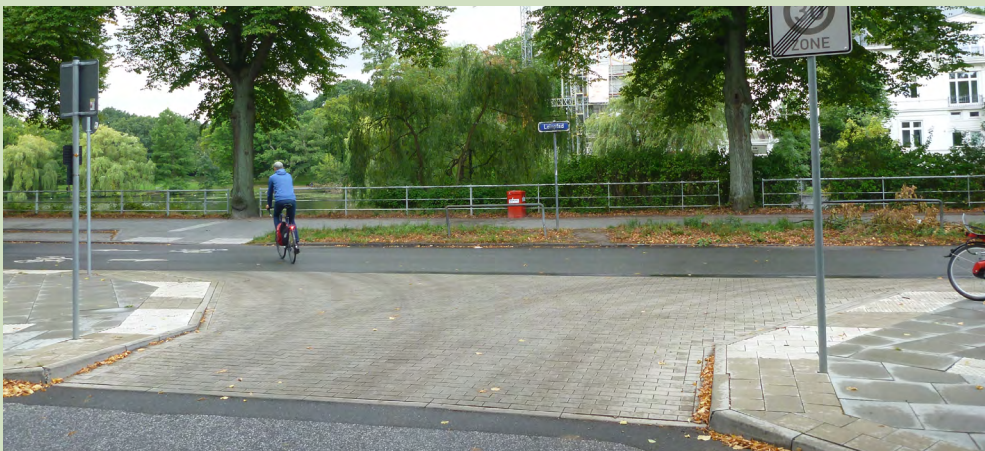
Abbildung 29: Gehwegüberfahrt am Leinpfad in Hamburg.
